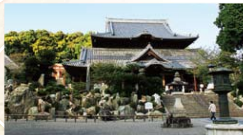
⑦ 本堂 (重要文化財) と名勝「粉河寺庭園」 本堂 1720 (享保五) 年の再建 西国札所の中で最大といわれる本堂。屋根が重なり合っ て、複雑な建築構造になっている。本堂前の石庭は、石組みと 植栽をあわせた国内でも珍しい庭園様式。
