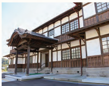
漱石の講演が行われた旧和歌山県議会議事堂。現在は、岩出市根元に移築
